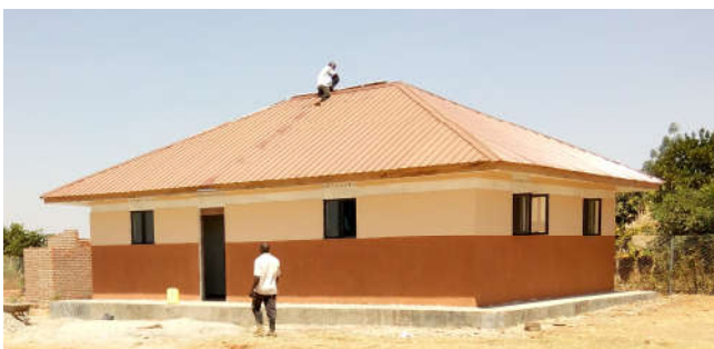
Nebengebäude: Installation d. Solaranlage an d. Rückseite
