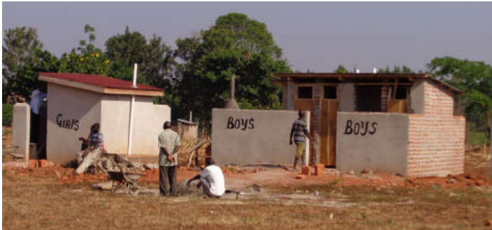
Fertigstellung der Toilettenhäuser
