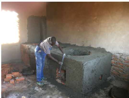
Verputzen des Lehmofens in der Küche
