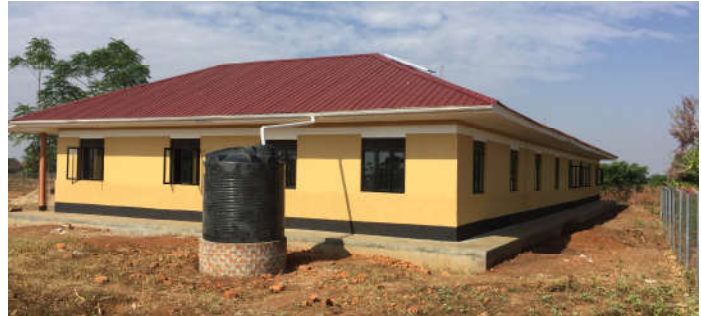
Schulgebäude: Wassertank an der Rückseite
